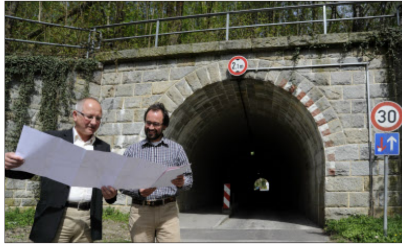
Der Mühlbogentunnel heute: Alois Wanninger und Kreisheimatpfleger Florian Jung gleichen die Baupläne der Reichsautobahn Nr. 87 mit dem Bauwerk im Original ab. – Foto: Roland Binder
