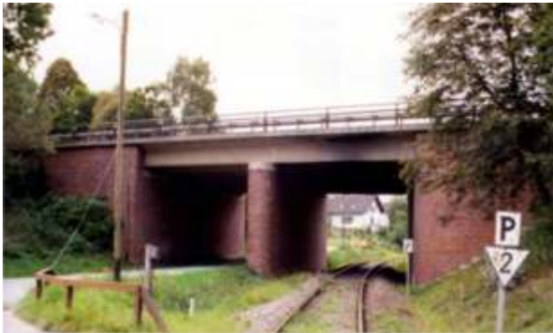
Unterführung Bahnline und Verbindungsstraße bei Wolnzach
