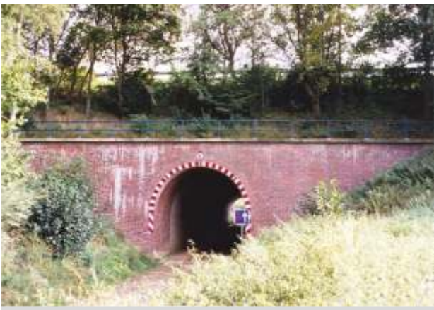
Unterführung bei Beigelswinden von beiden Seiten
