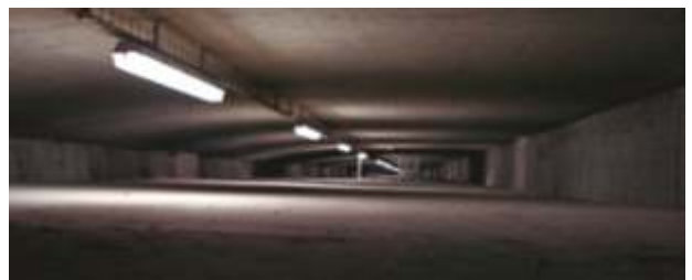
Im Hohlkasten des Überbaus
