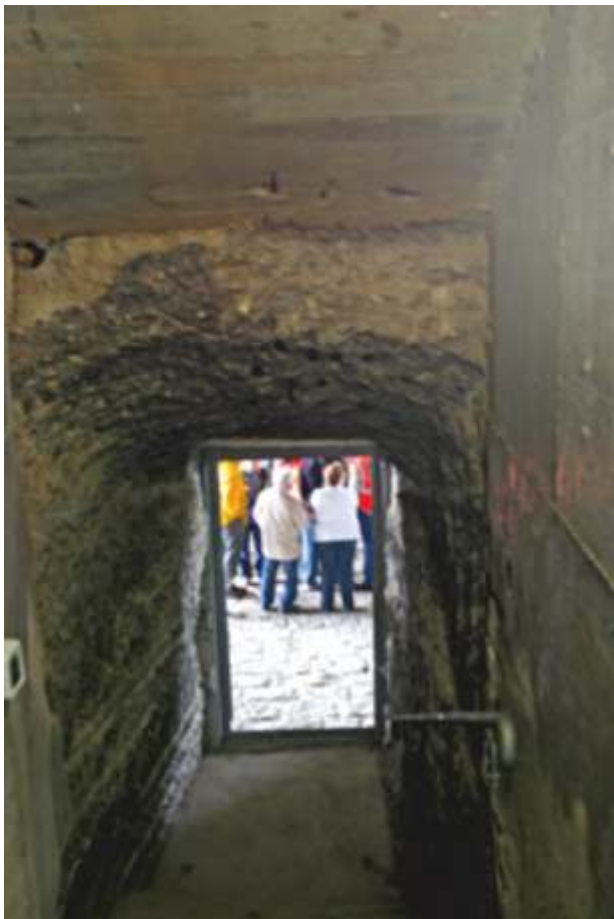
Zugang zum nördlichen Widerlager
