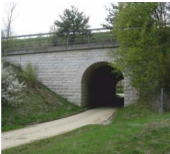
Unterführungen aus RAB-Zeiten als Bauvorleistungen an der A 93
